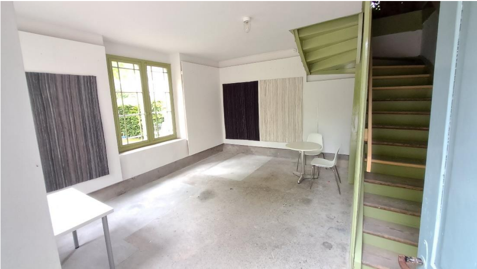
Raum links Waschhaus
