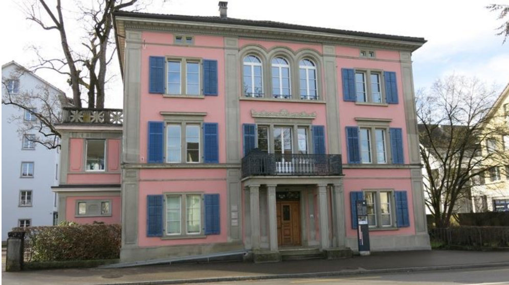
Mit rollstuhlgängiger Rampe – Lift vorhanden
