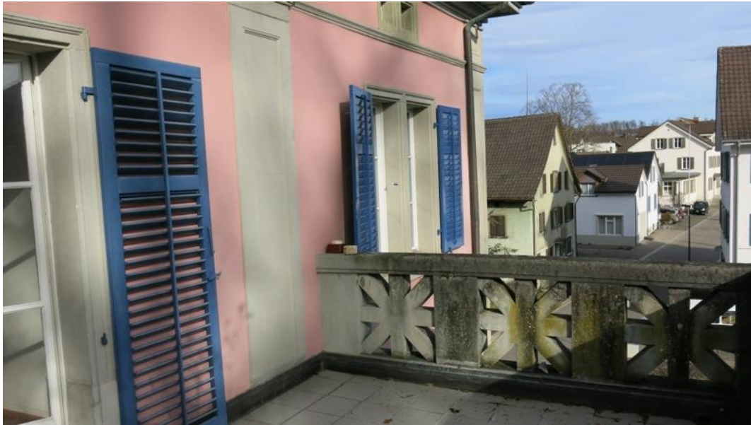
Terasse, erreichbar über den Apéroraum
